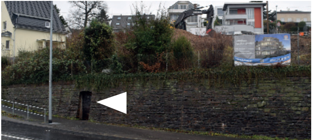
Hinter dieser Tür geht es per Treppe rund sechs Meter tief in den Luftschutzstollen hinunter. Dort unten wurde die Kriegsmunition gefunden. Foto: Schupp
